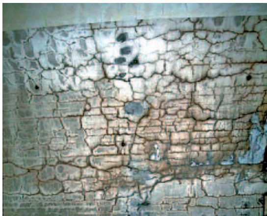
Ryc. 1. Typowy obraz szkodliwego działania reakcji pomiędzy alkaliami a aktywną krzemionką z kruszywa [3]
