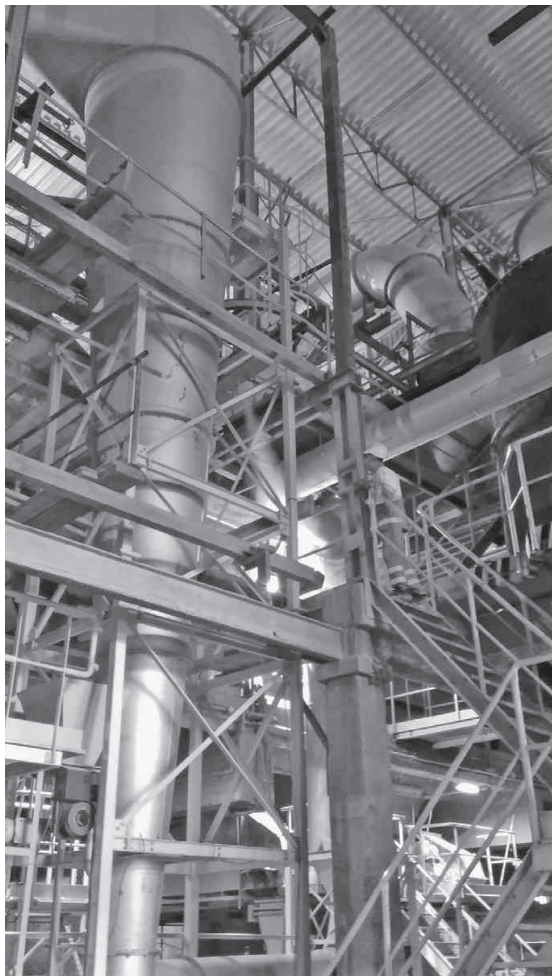
Ryc. 2. Widok stanowiska doświadczalnego
