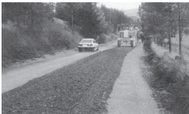
Ryc. 1. Recykling i stabilizacja destruktu mas drogowych [4]
