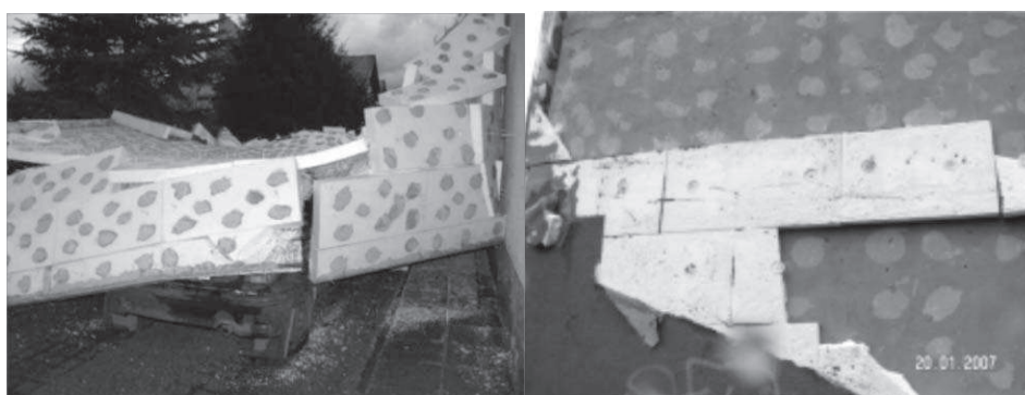
Ryc. 2. Skutki nieprzestrzegania zasady pasmowo-punktowej przy klejeniu styropianu (materiały szkoleniowe firmy Baumit)
