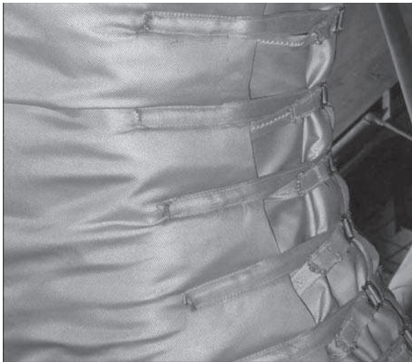
Ryc. 7. Izolacja kolan pyłowych
