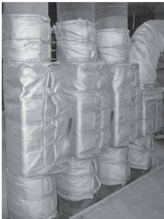
Ryc. 5. Izolacja przewodów pyłowych
