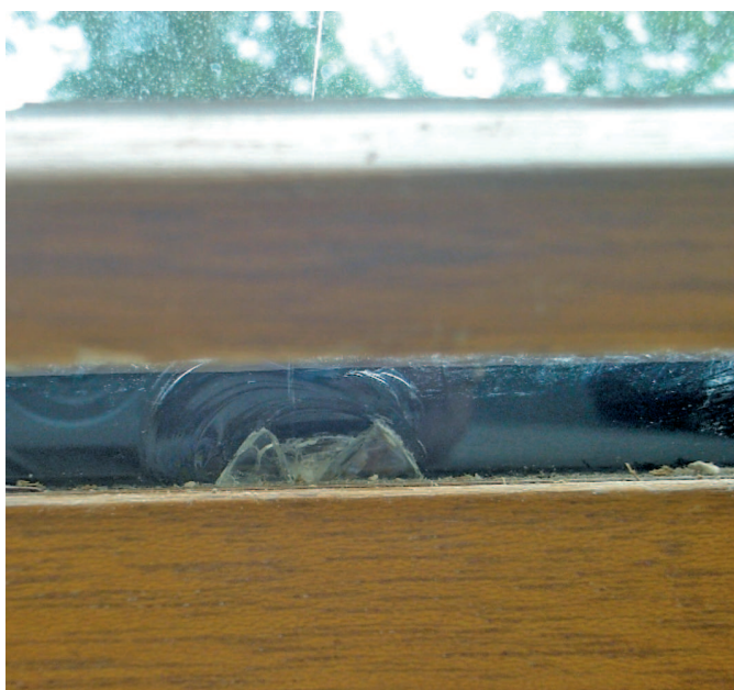
Ryc. 5. Odpryski na krawędziach szyb zespolonych
