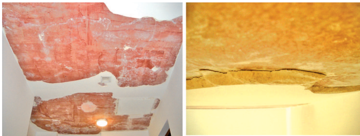
Ryc. 1. Przykłady odpadającego tynku ze stropów budynków mieszkalnych
