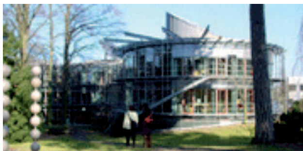
Ryc. 3. Niemiecka Federalna Fundacja Ochrony Środowiska (DBU). Osnabrück – pierwszy w Niemczech budynek wykonany z betonów na kruszywach z recyklingu [4]
